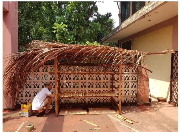
Construction d'un abri pour des plantes
