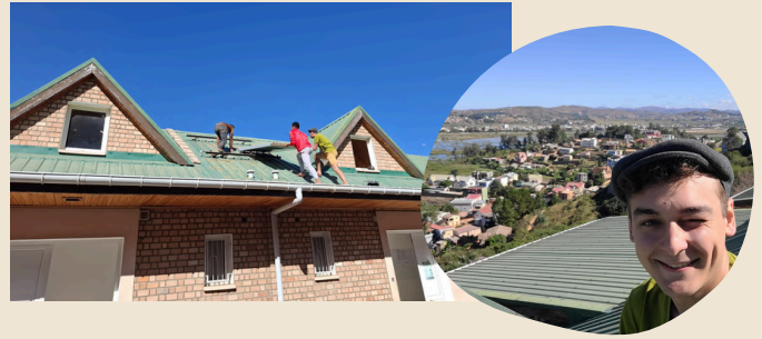
Vue du toit
